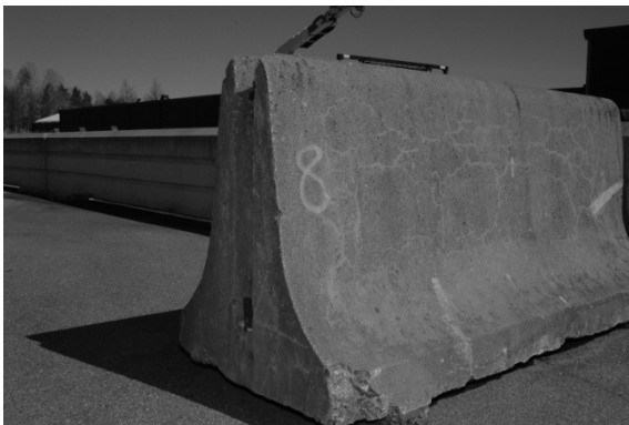
Det klassiska tric-bloc. Detta räcke är inte EN1317-godkänt.
