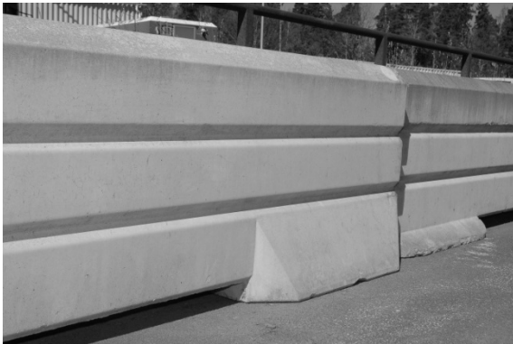
Betongräcke som är krockprovad enligt såväl EN1317-2 som amerikanska NCHRP 350. Räcket har ett giltigt CE-märkningstillstånd. Räcket har en slät ovansida och är knappt metern högt.
